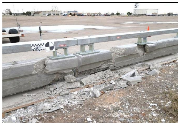
(d) Field side of bridge rail
