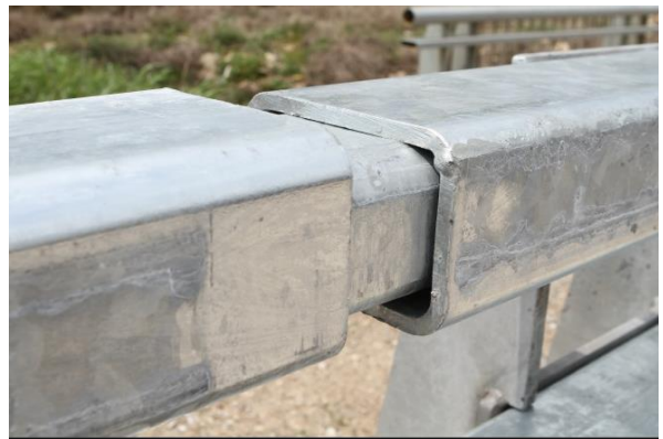
(d) Metal joint and sleeve
