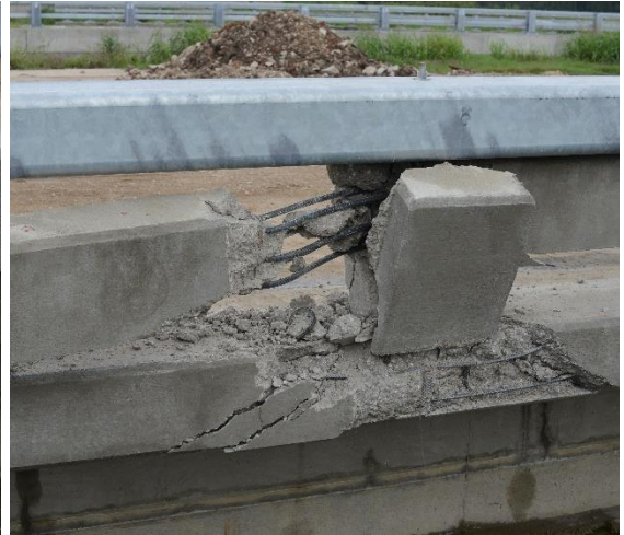
(d) Field side of middle post of section 3
