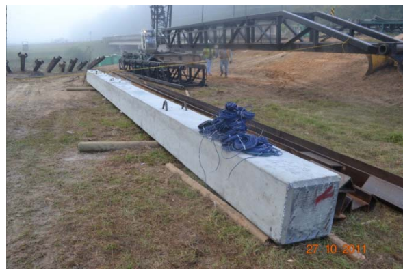
(b) Test Pile
