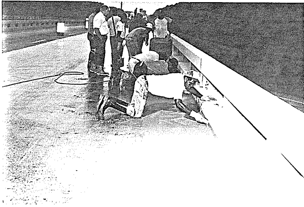
Hand Troweling of Cono/Crete 101
