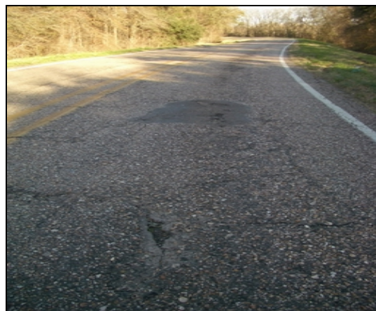
(f) Pavement Patch (LA 354)
